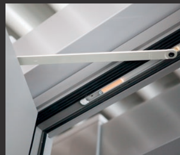
Im Türblatt verdeckter Türschließer
